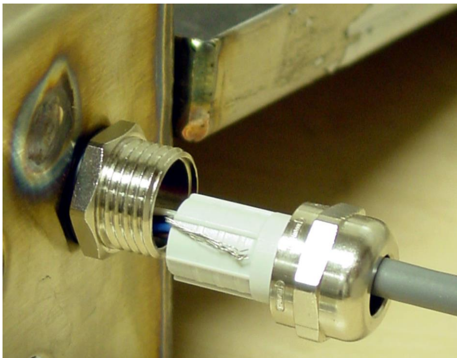
FIGURA NO. 10 CONEXIÓN DEL BLINDAJE DEL CABLE DE LA CELDA DE CARGA
